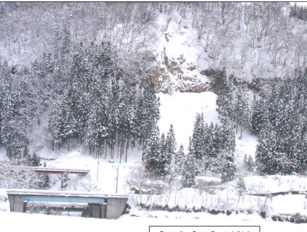
土砂崩壊現場
