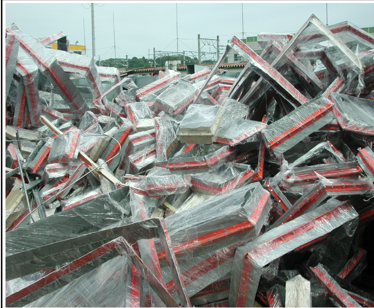
幹総内に山積みされたダクト。震災被災地の瓦礫の山のような。ビニールに覆われているが破れて穴もある。
