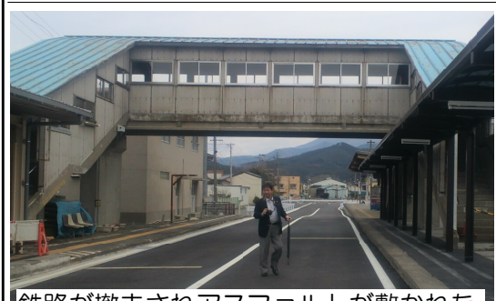
鉄路が撤去されアスファルトが敷かれた
