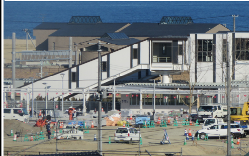
工事中の新地駅を新地町役場から見学
